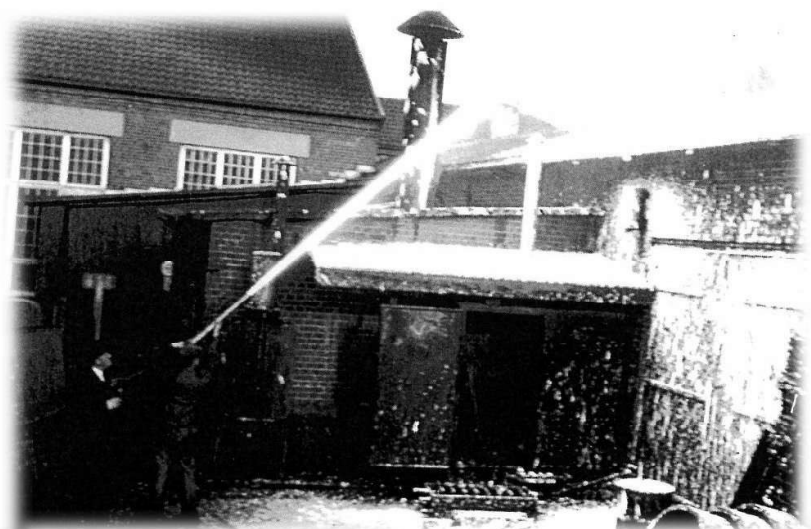
Test av skumsläckningsaggregat på gården i Vellinge
