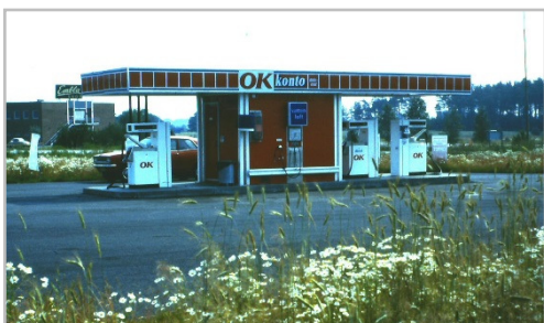
Bild på obemannad OK-station i Blekingeprojektet
